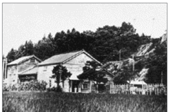
大久保発電所
